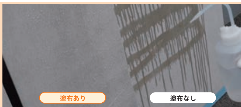
コンクリート表面のはっ水状況
