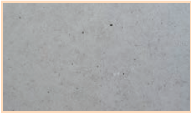
塗布後の外観状況 (無色透明)
